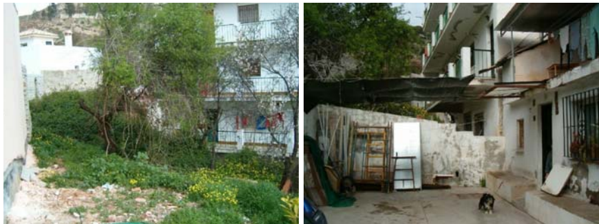
Situaciones de borde urbano
